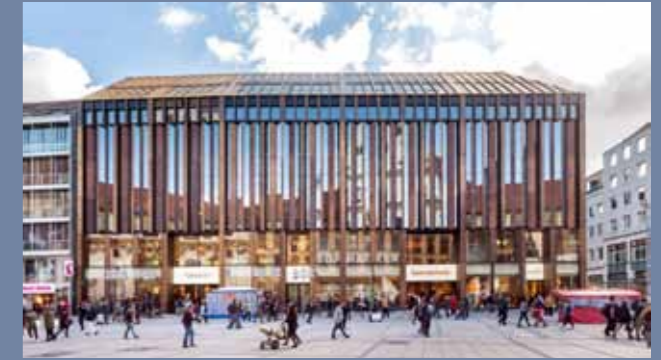
JOSEPH PSCHORR HAUS Lage: Fußgängerzone; © Bayerische Hausbau
